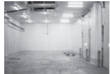
รูปที่ 11-17 งานก่อสร้างพื้นคอนกรีตห้องเย็น จำเป็นต้องใช้คอนกรีตที่ใส่สารกระจายกักฟองอากาศ
