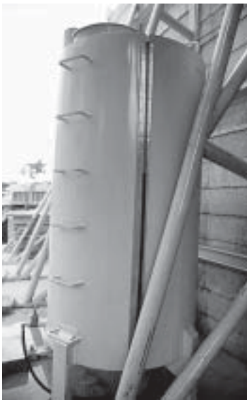
รูปที่ 11-4 การเก็บรักษาสารเคมีผสมเพิ่มไว้ในถังที่ปิดมิดชิด ในโรงงานคอนกรีตผสมเสร็จ
