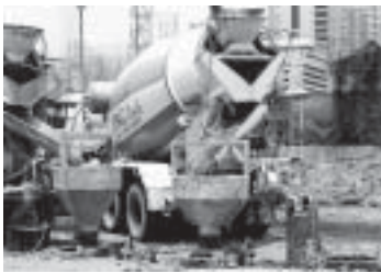
รูปที่ 11-9 งานเทคอนกรีตกำแพงพืด (Diaphragm Wall) จำเป็นต้องใช้สารผสมเพิ่มประเภทที่มีคุณสมบัติหน่วงการก่อตัวของคอนกรีต เพื่อให้มีระยะเวลาทำงานเพียงพอ
