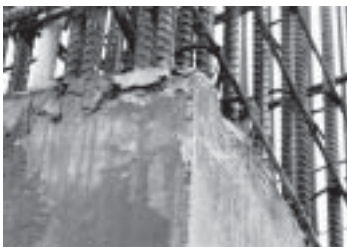
รูปที่ 11-10 ผลของการใส่สารหน่วงการก่อตัวในคอนกรีตเกินปริมาณที่กำหนด ทำให้คอนกรีตมีเนื้ออยู่และไม่แข็งตัว
